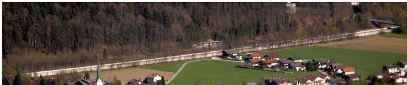
Am 26.04.2011 beginnt die ASFINAG mit der Neuerrichtung der Lärmschutzwand. Die neue Wand, die Ende Dezember 2011 fertig gestellt wird, erreicht eine Höhe von 3,50 bis 5,00 m, das bedeutet eine Vergrößerung der Lärmschutzfläche von 29 Prozent. Sie wird nach dem neuesten Stand der Technik (hochabsorbierend) errichtet und zudem wird auf der Richtungsfahrbahn Kufstein der lärmindernde Splitt-Mastixasphalt aufgetragen.
